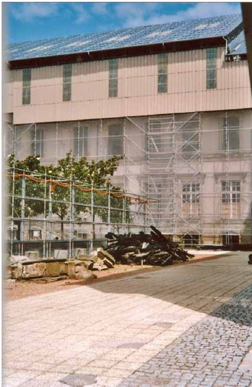
Chantier. Photo A. Pecqueux, 2004.
