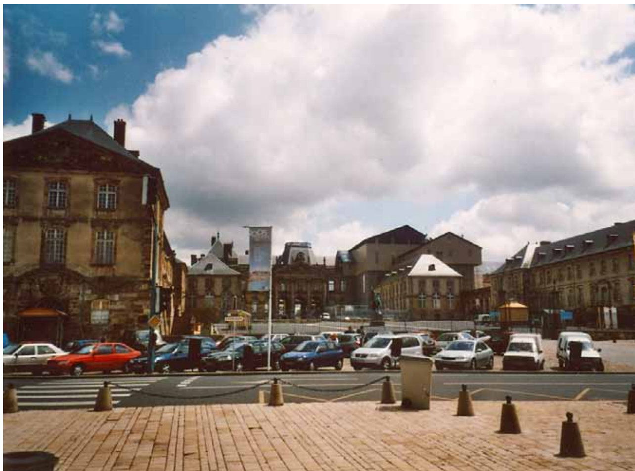
Le château de Lunéville. Au fond à droite la partie détruite en cours de reconstruction et surmontée du parapluie. Photo J.-L. Tornatore, juillet 2005.
